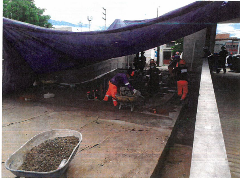
Fotografía N°03: Habilitación de Acero, Encofrado y Concreto en Rampa Vehicular
