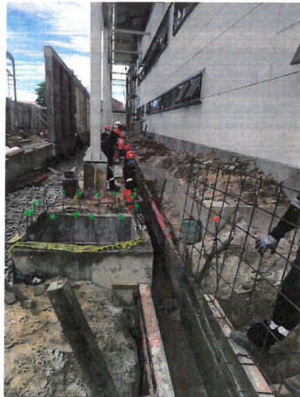
Fotografía N°04: Concreto F'c = 210 Kg/cm2 Cimentación Muro corte 6' Frente al bloque A
