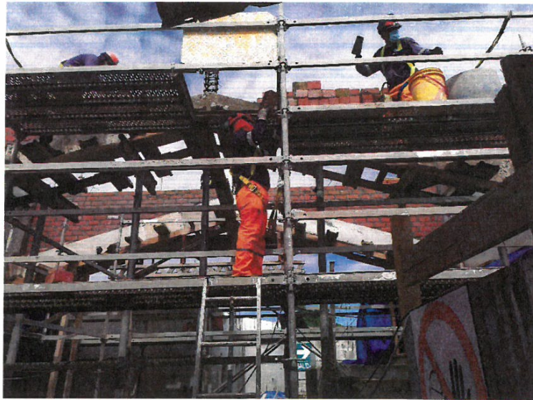
Fotografía N°05: Asentado de Ladrillos entre las vigas del bloque F
