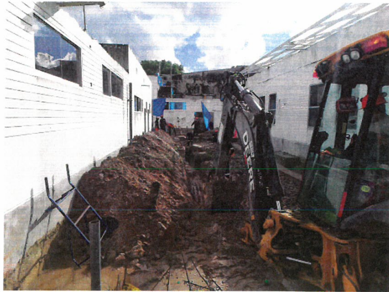
Fotografía N°7: Excavación de Cimentación para Muro
