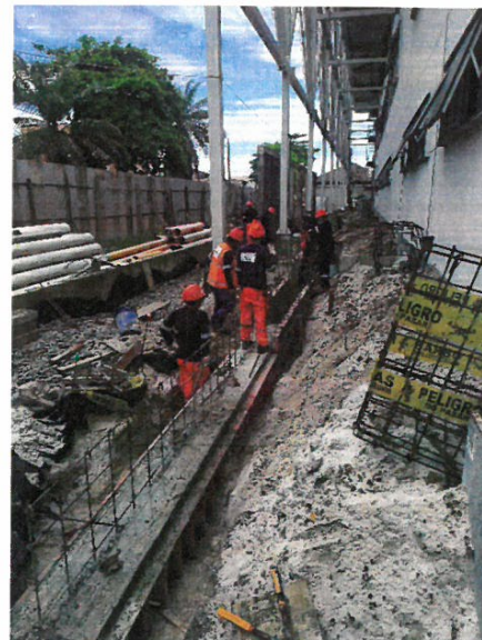
Fotografía N°04: Concreto F'c = 210 Kg/cm2 Cimentación Muro corte 6' Frente al bloque A
