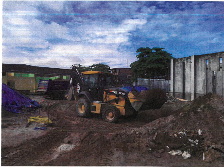
Fotografía N°01: Eliminación de Material, Cargador 125 HP
