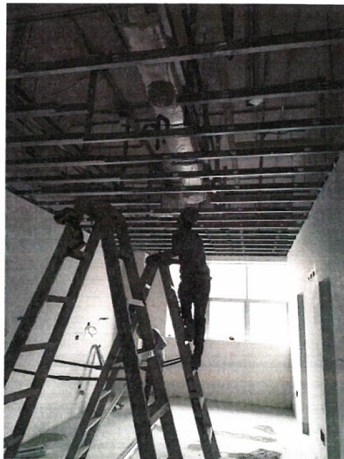
Fotografía N°8: Falso Cieloraso
